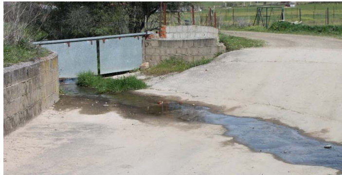
Foto: Vista del Arroyo del Molinillo en su cruce con el camino de utilidad pública de acceso al apoyo T-6.
