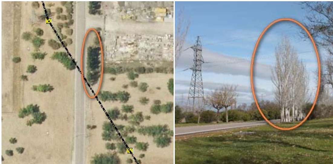
Detalle y foto de zona de tala de chopos por servidumbre de vuelo en el vano T-1-T-2
