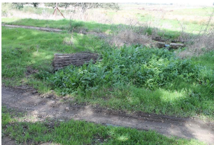
Foto del canal junto el acceso al apoyo T-4 en un tramo a acondicionar
