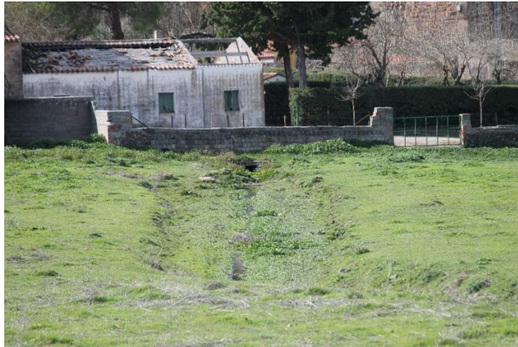
Foto canal de Valdecañas en la finca del apoyo T-11
